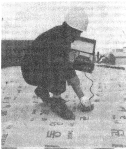
사진 : 도장 두께 측정
