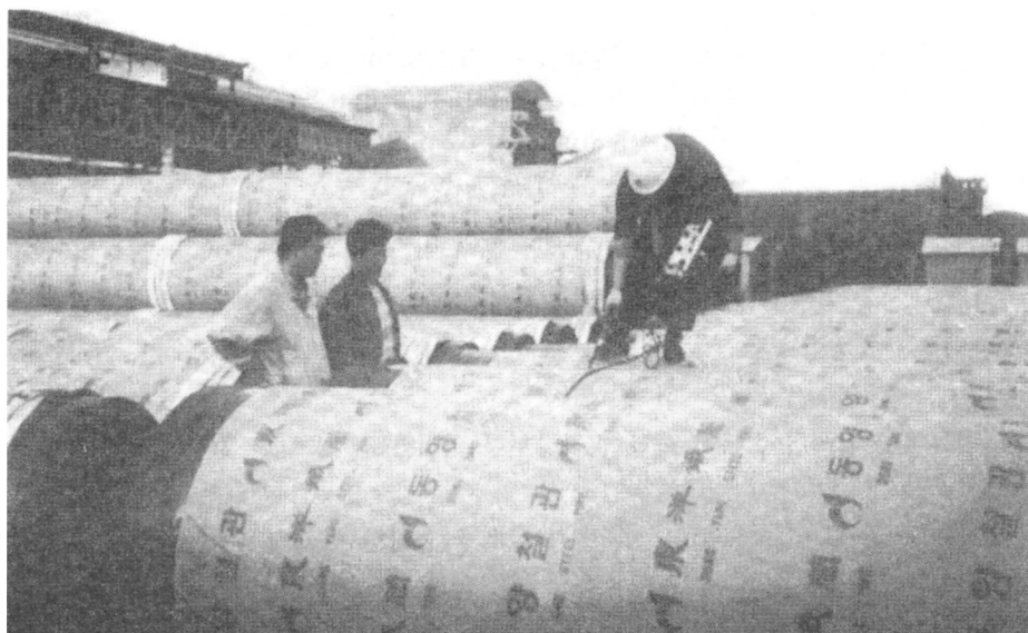
사진 : 외면도장 입회 절연검사
