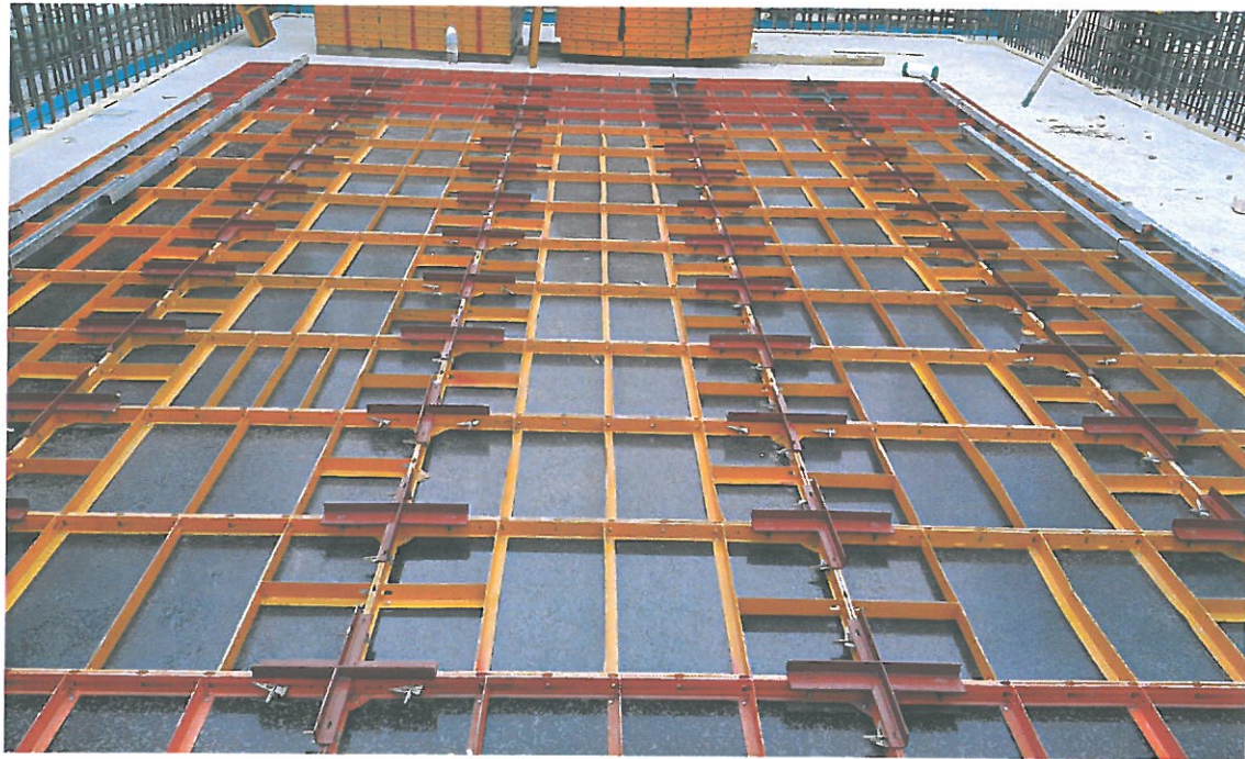
유로폼 및 거성 +자형 조인트 선조립 상태
